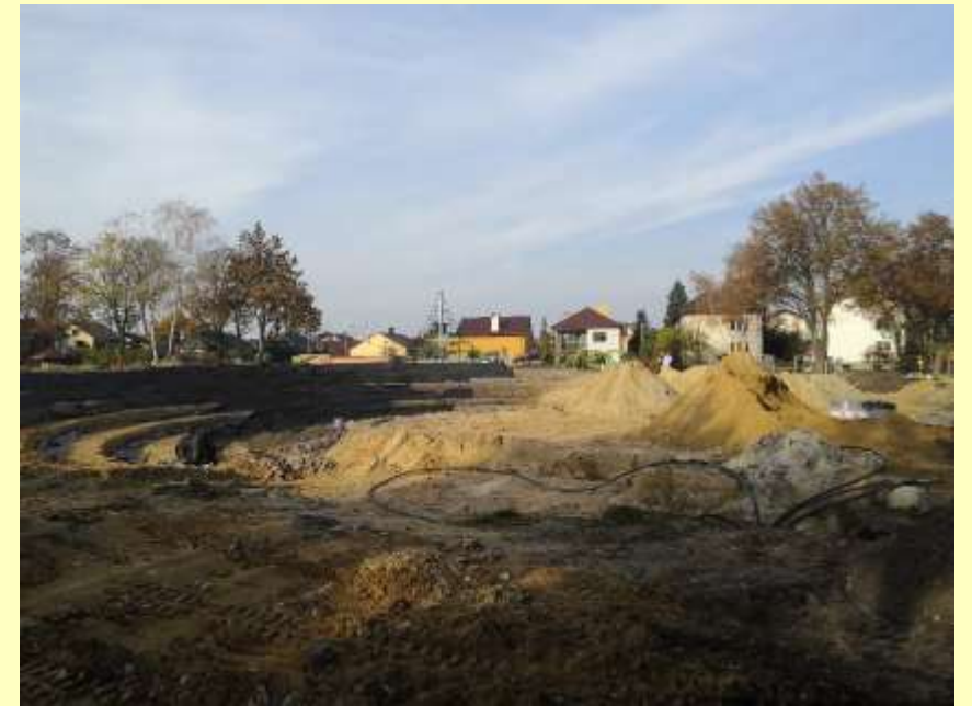
Budowa amfiteatru w trakcie realizacji
