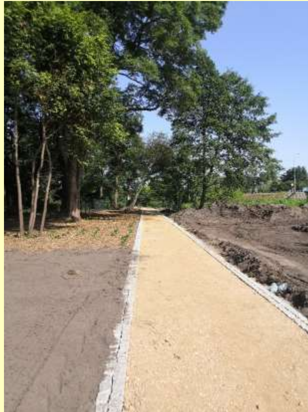
Budowa ciągów komunikacyjnych w trakcie realizacji
