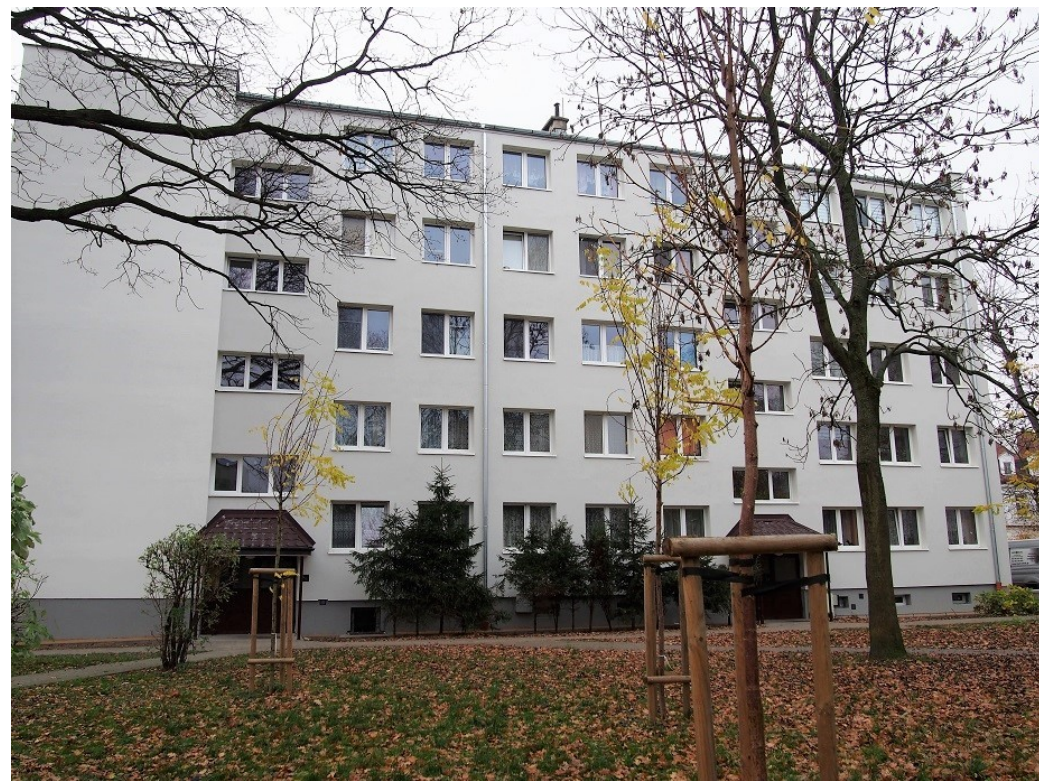
Po realizacji – Dąbrowskiego 5
