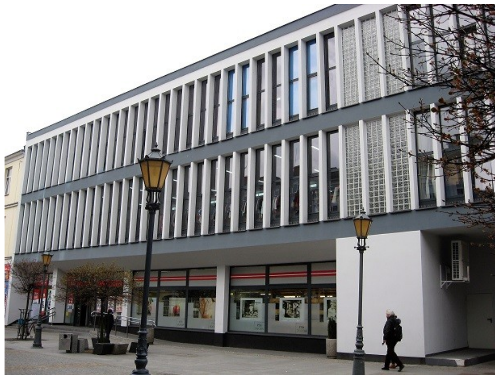
Po realizacji – Tumaska 11a
