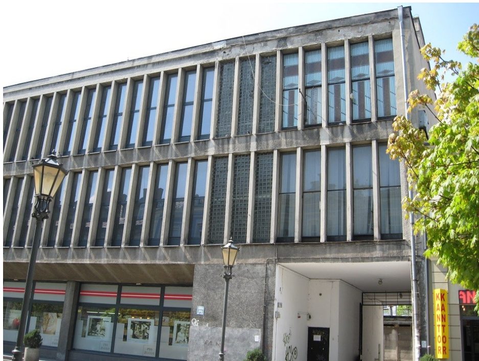
Przed realizacją – Tumaska 11a
