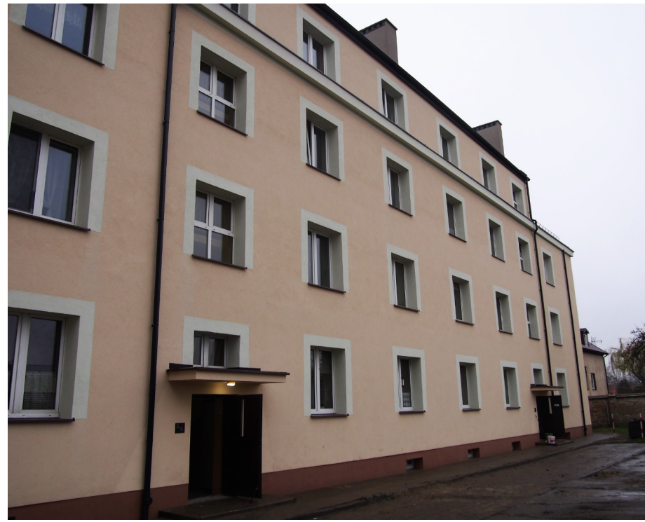
Po realizacji – Ostatnia 4
