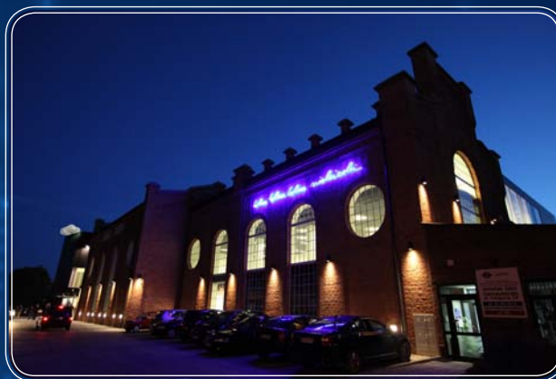
Zmiana sposobu użytkowania dawnej elektrociepłowni na Mazowieckie Centrum Sztuki Współczesnej Elekrownia w Radomiu
