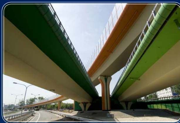
Budowa Trasy Siekierkowskiej, odcinek IIB od węzła Bora-Komorowskiego do ul. Płowieckiej
