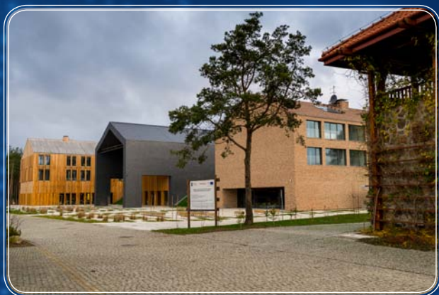
Budowa centrum kulturalno-rekreacyjnego w Muzeum Wsi Mazowieckiej w Sierpcu
